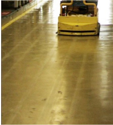
Bild 3: Abnutzungsspuren bei Fahrzeugen mit fester Spurführung
